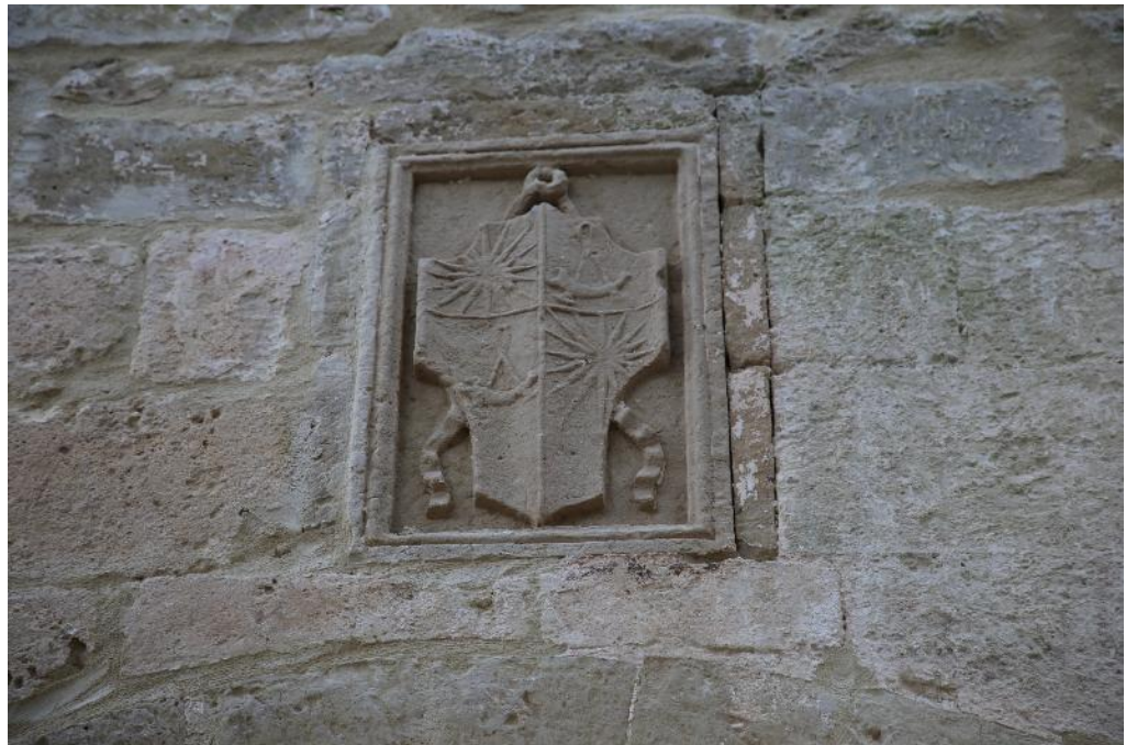
Carpignano Salentino, MUS.AR.CA , Prospetto del Palazzo Ducale su Via Roma e particolare dello stemma dei Del Balzo in facciata, ph. Paola Durante, 2026
