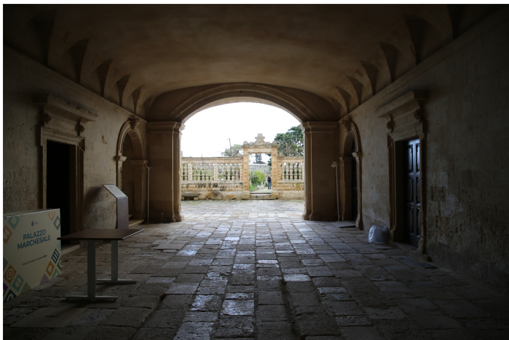
Melpignano, Palazzo Marchesale Castriota, (in ordine) Prospetto principale; Androne; Vista dal cortile sul giardino, ph. Paola Durante, 2026
