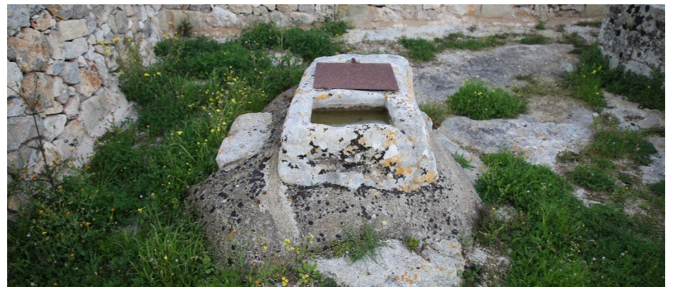
Castrignano de' Greci, Masseria Mauro Monico, (in ordine) Prospetto sud su Via Vecchia Serre; Cisterna esterna prospetto ovest; particolare del secondo boccapozzo della cisterna esterna, Ph Paola Durante, 2026
