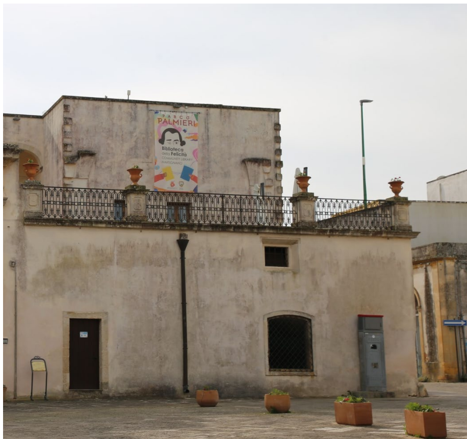
Martignano, Ingresso Frantoio semi-ipogeo su Piazza Palmieri, ph. Paola Durante, 2026
